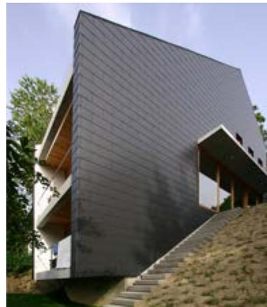
Angelehnt an die Bebauung der Nachbarschaft wurden die Fassade und das Dach einheitlich mit Faserzementplatten bekleidet.
