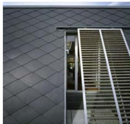
Für die Bekleidung wurden Faserzementplatten mit einem Format von 40 x 44 Zentimeter verwendet. Ein zusätzliches Gestaltungselement sind die Schiebeläden, die mit ihrer vertikalen Lattung einen schönen Kontrast zum Wabenmuster bilden.
