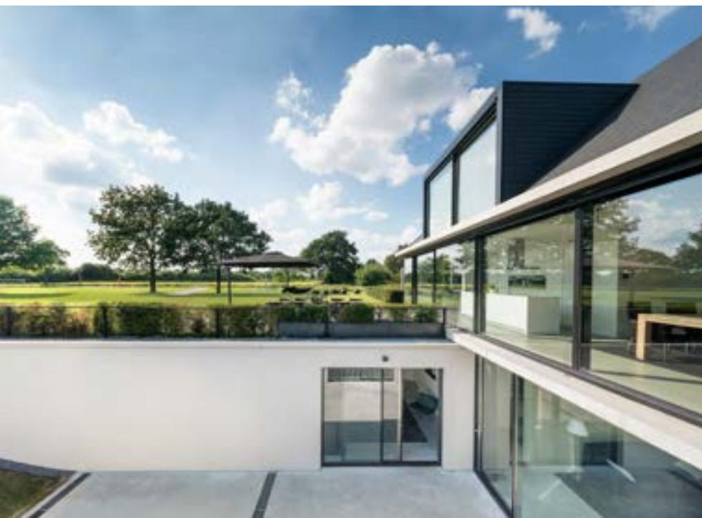
Das sehr leicht, fast schwebend wirkende Dach ist mit dunklen Faserzementplatten gedeckt, deren glatte Oberfläche einen schönen Kontrast zu den großen Glasflächen bildet.
